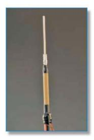
Paso 1. Ponga el cable en posición y corte el largo. Usando las prácticas estándar, corte la tira o lengüeta del cable, la pantalla metálica, pantalla semiconductora y el aislamiento del cable mostrando el conductor.
