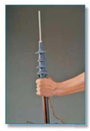
Paso 8. Tire la guía en el lugar correcto, y el núcleo removible se comprimirá.
