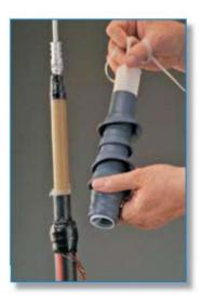
Paso 6. Jale la cuerda final suelta del núcleo, hasta que coincida con el final del encapsulado de la terminal aris.
